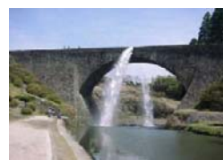
涼しげな通潤橋
